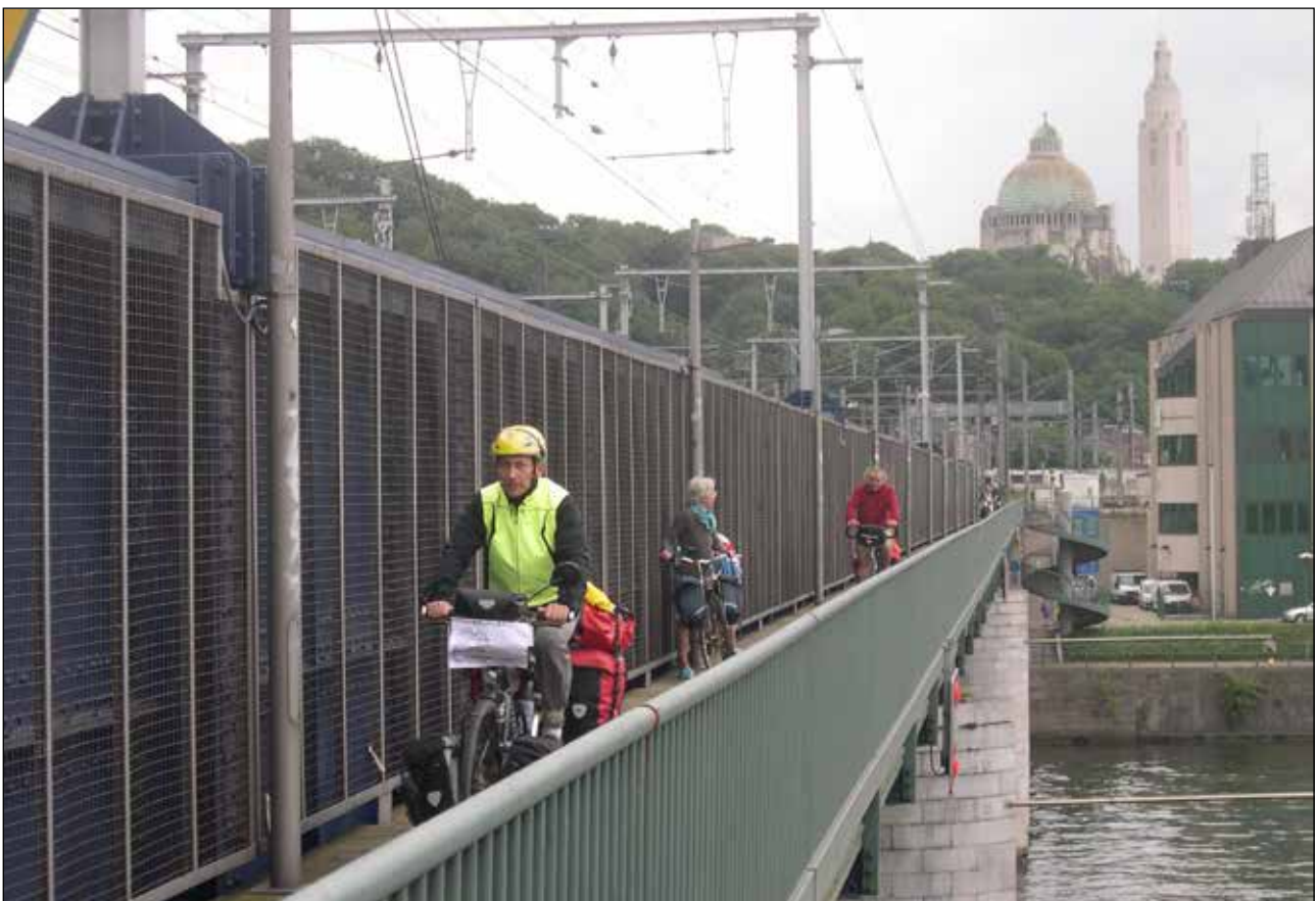
Een spoorwegbrug in Luik (Dynamobile 2011)
