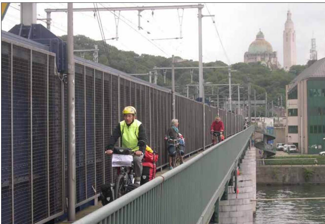
Un pont-rail à Liège (Dynamobile 2011)
